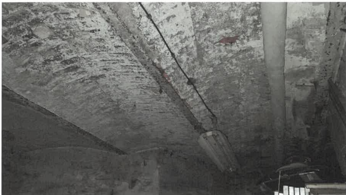
Fot. 1 – Zdegradowane stropy odcinkowe na piwnicą
