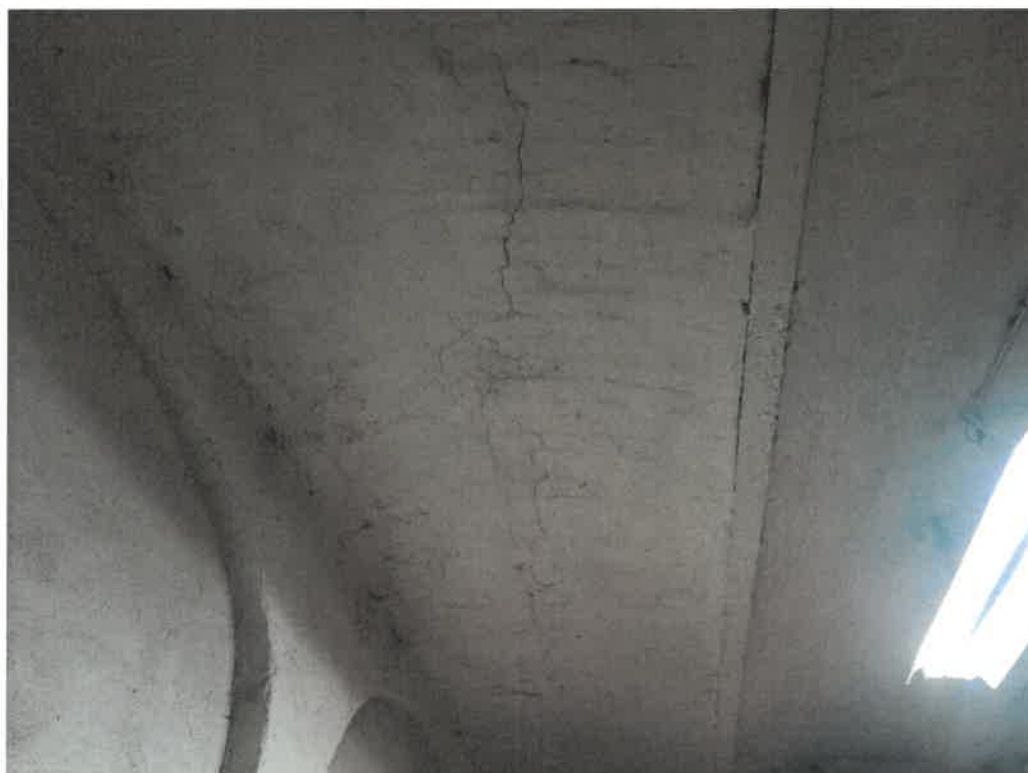
Fot. 2 – Uszkodzenia stropów odcinkowych
